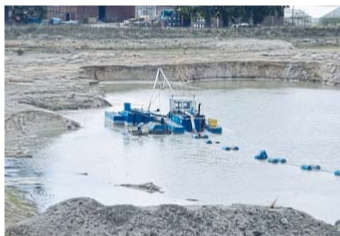
Bagger-Loch: Unter Wasser, am Boden des Sees, wird der Sand abgesaugt. Der Wasseranteil wird nach dem Vorgang wieder in den See abgeschieden. FOTO: FRANK JASPER
